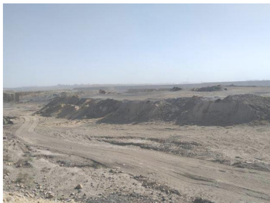
照片 1-14 回填欣源煤矿采坑
