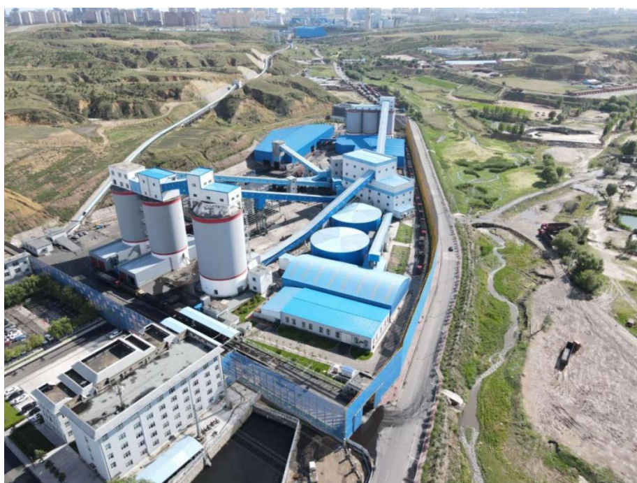
照片 1-1 工业场地主要生产区
