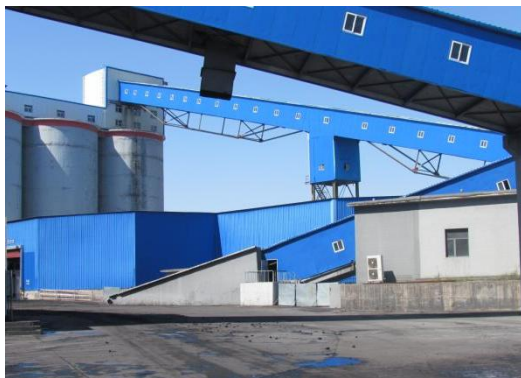
照片 1-6 主井生产区
