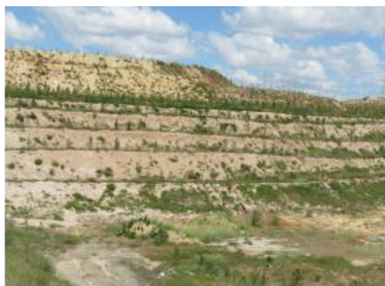
照片 1-10 矸石场（东边坡）
